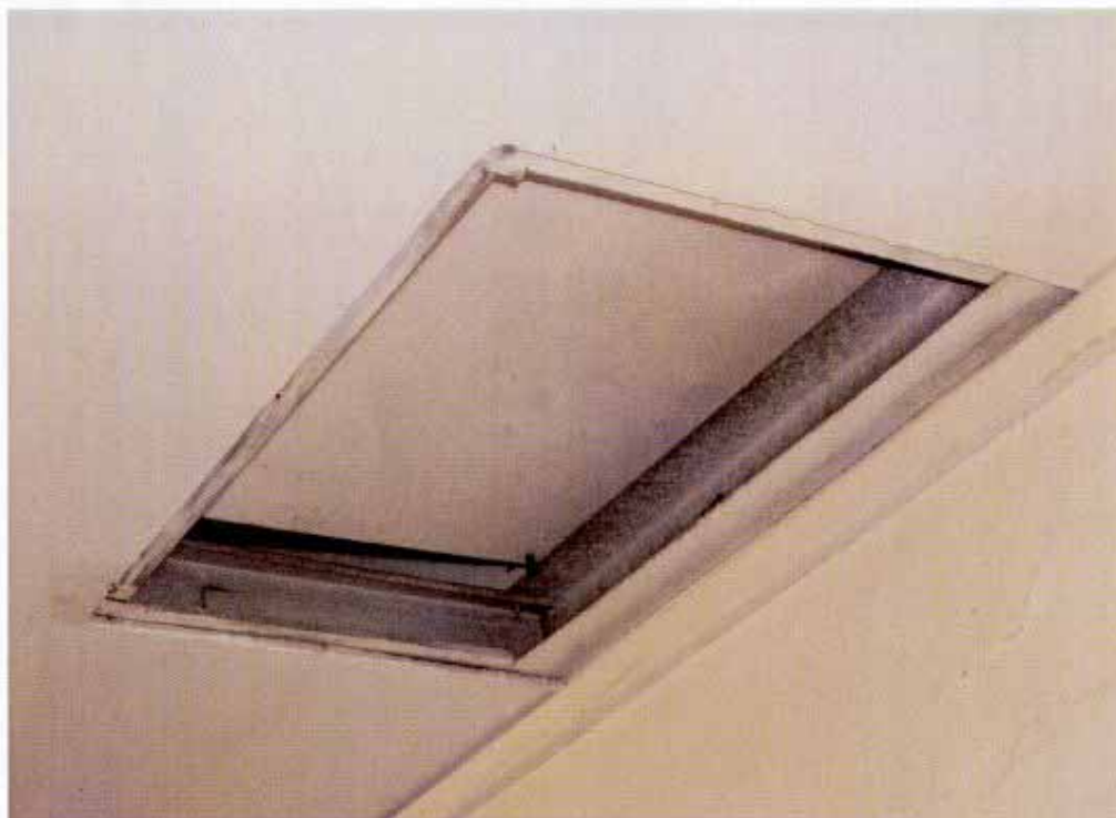
Obr. 9/V - zavěšený pohled z azbestocementových desek
