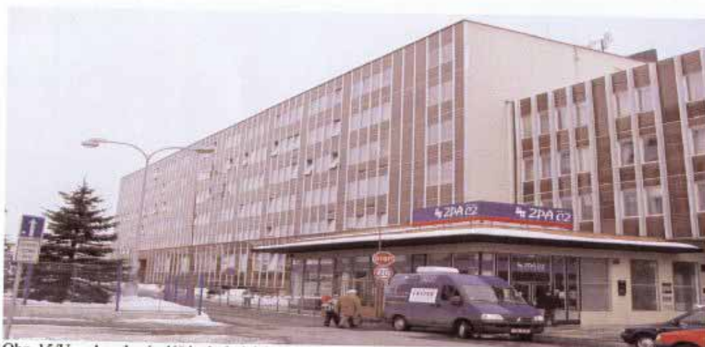
Obr. 15/V - obvodový plášť - boletické panely
