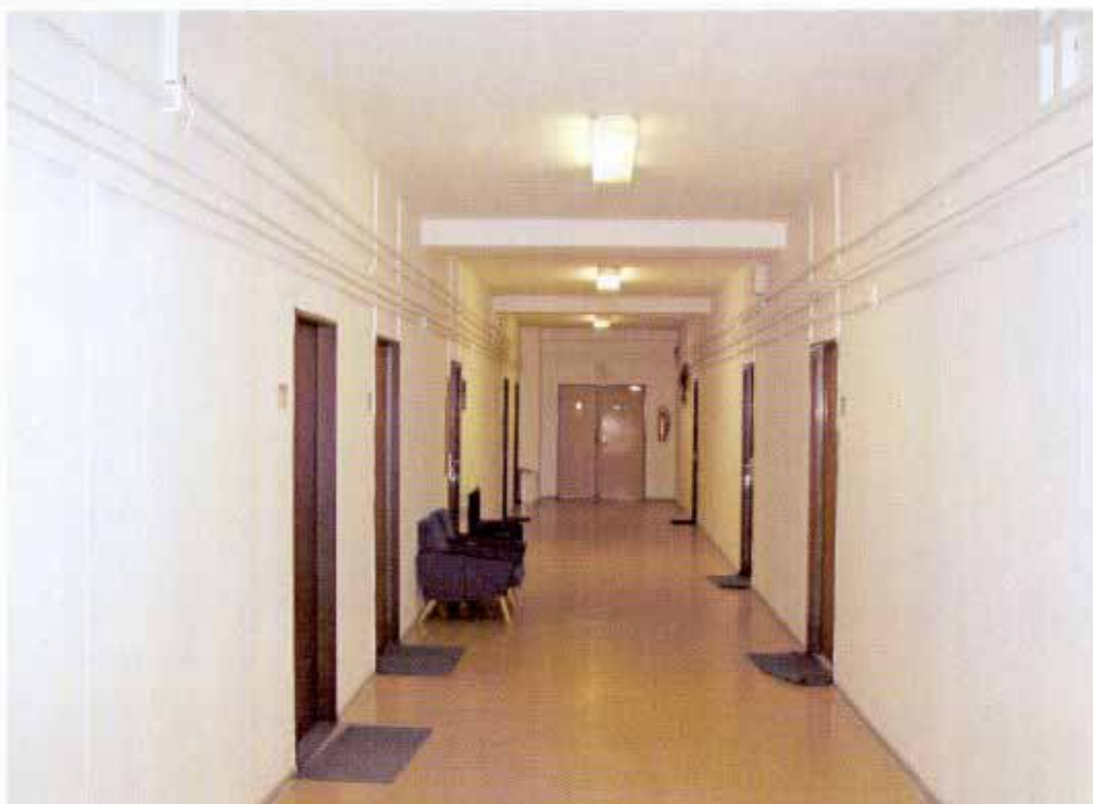
Obr. 8/V - pohled do chodby administrativního objektu, prefabrikované příčky typu FEAL, jejichž obě strany jsou z azbestocementových desek a uvnitř je minerální izolační vata.
