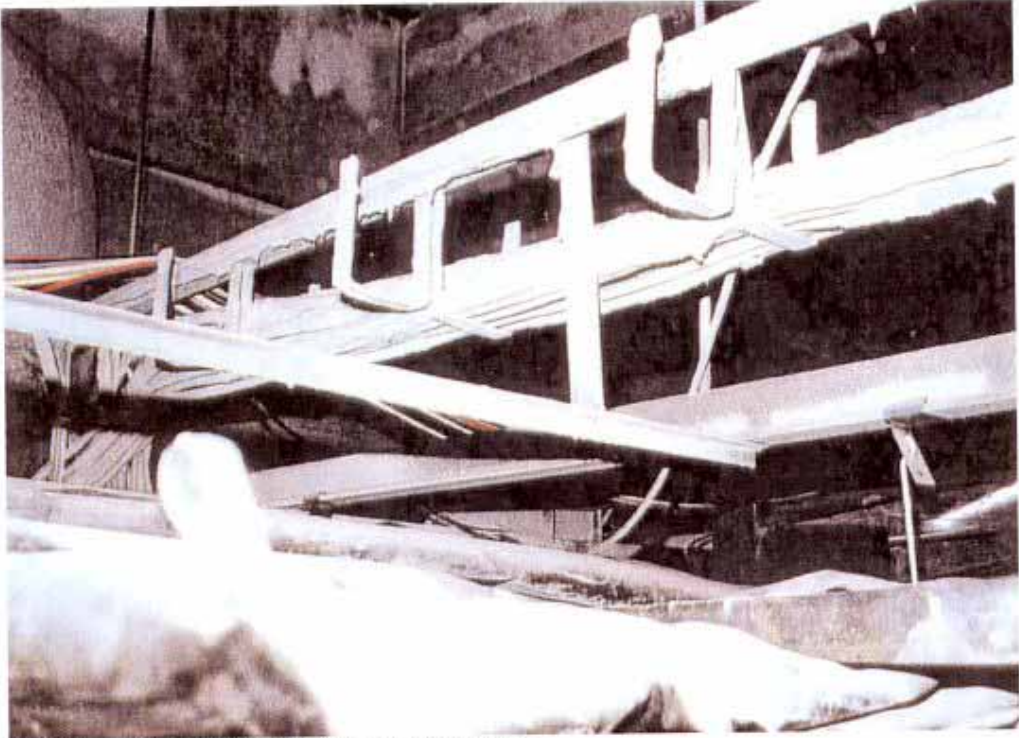
Obr. 4/V – nástřik kabelů maltovinou s obsahem azbestu
