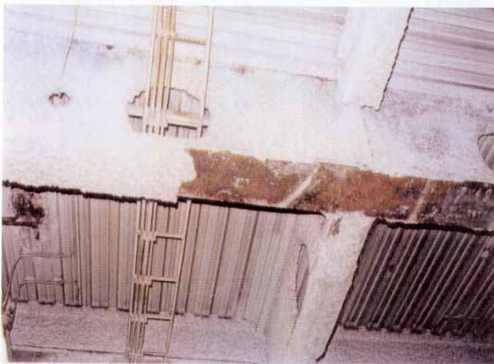
Obr. 7/V- část budovy má ocelovou konstrukci nástřikanou maltovinou bez azbestu
