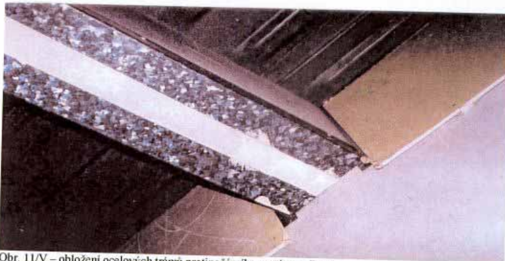
Obr. 10/V – izolace vzduchotechnického potrubí. Azbestocementové obkladové desky.
