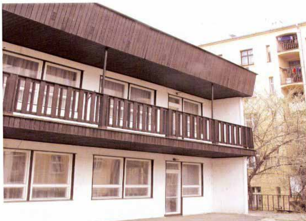
Obr. 23/V – dřevostavba – vnější obkladová azbestocementová deska
