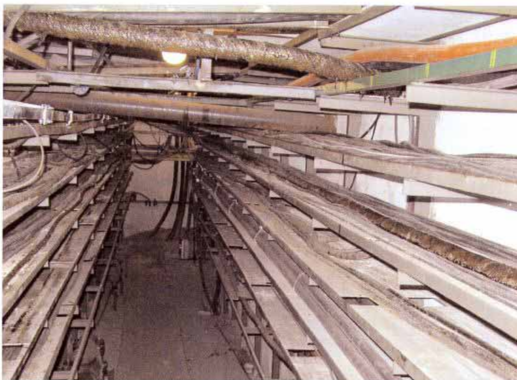
Obr. 18/V – kabelový prostor s azbestocementovými deskami
